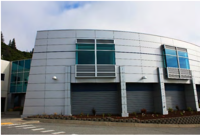
SPH Existing Façade
